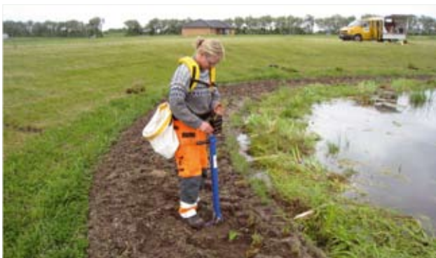
Örtplugg planteras med Veg Techs planteringssystem och Veg Techs strandmattor är förankrade vid strandkanten.
