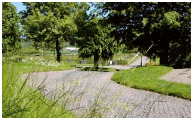
Pelleplattan fylld med singel på gångväg
