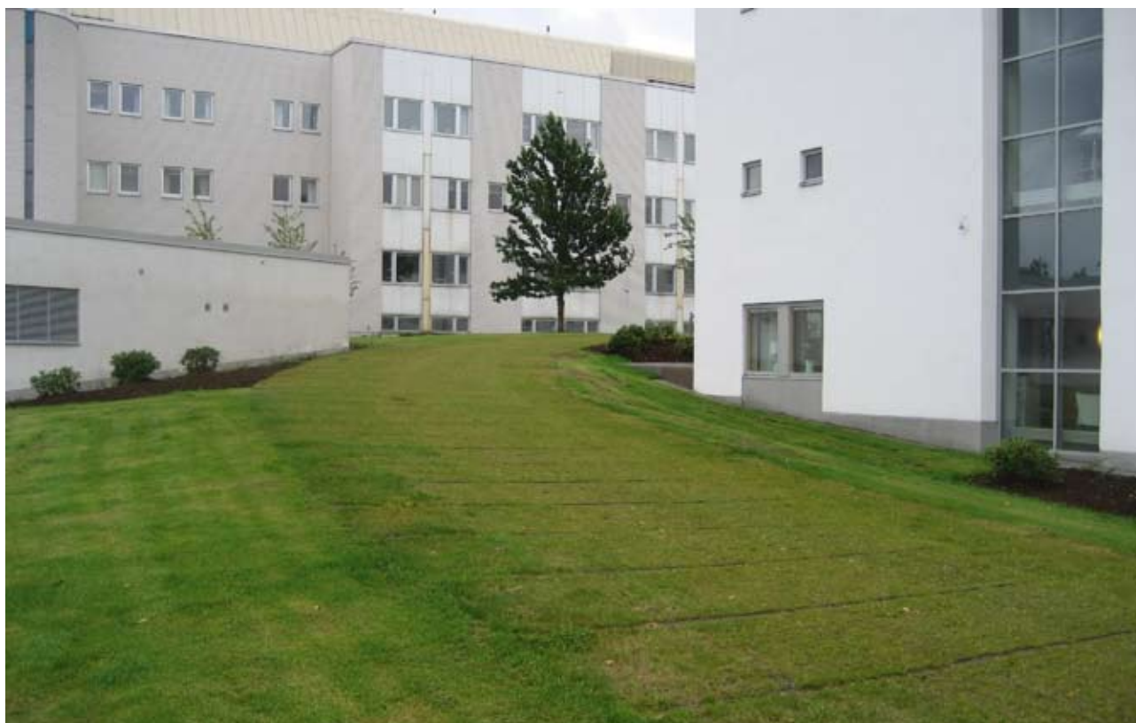
Brandväg av Pelleplattor vid sjukhus
