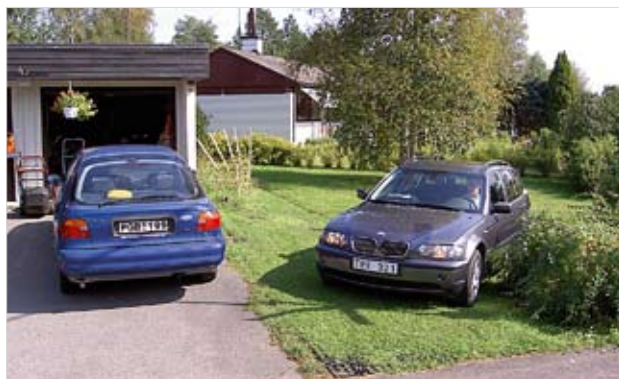
Efter: Pelleplatta Ontop döljs av gräset som vuxit upp genom plattans celler. Gräset kan klippas på vanligt vis.
