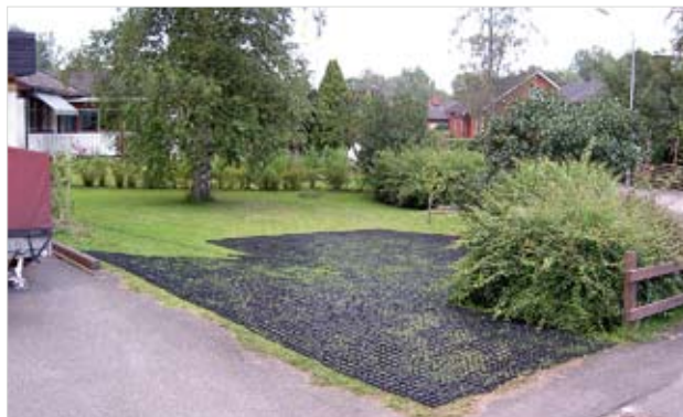
Före: Pelleplatta Ontop utlagd ovanpå en befintlig gräsmatta för att skapa en extra parkeringsyta.
