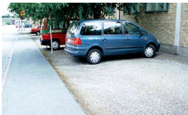
Pelleplattan som beläggning på parkeringsyta
