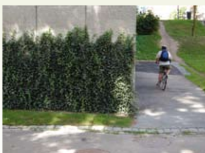
Växtskärmar skyddar fasaden mot klotter
