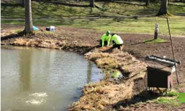
Vid restaurering av en parkdamm i området hälsostaden, Ängelholm anlades strandmattor, maxipluggplantor och ängsmattor.
