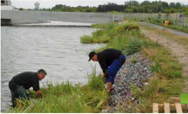
Dagvattendamm i bostadsområde utanför Köpenhamn.
