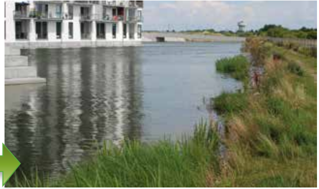
Tre veckor efter anläggning.
