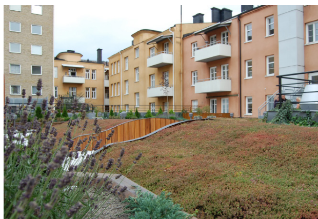
Sedum på takbjälklag i Norrköping
