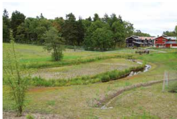
Här leds dagvattnet ned till en översilningsyta som i sin tur fördröjer och renar dagvattnet innan det förs vidare. Dagvattenprojekt Tollare park, Nacka kommun.
