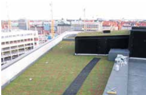
Ontop - gångstråk på sedumtak - gröna tak
