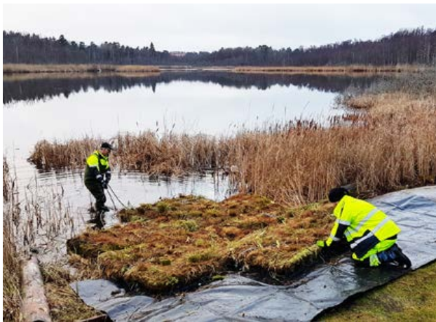
Veg Tech erbjuder entreprenadtjänster och utför installation av flytande våtmark.
