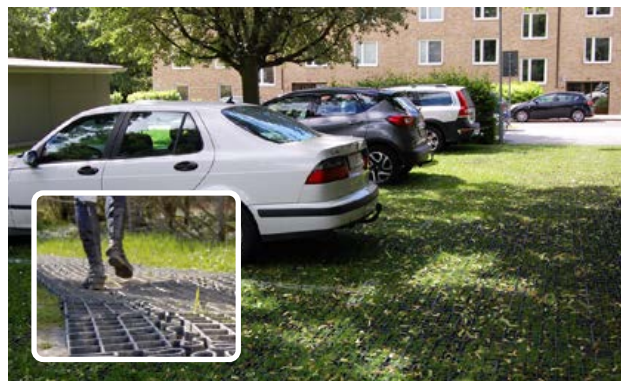
Pelleplatta OnTop utlagd ovanpå befintlig gräsmatta för att skapa en tillfällig parkeringsyta.
