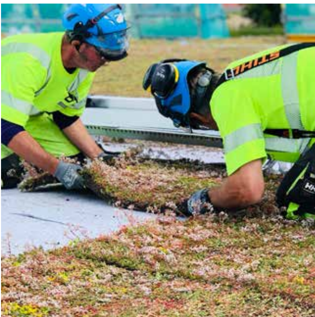
Montage av sedumtak med biokol sommaren 2020 på förskola i Vellinge.
