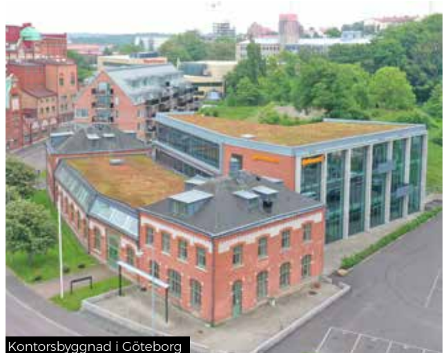
Kontorsbyggnad i Göteborg
