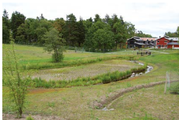
Dagvattnet leds ned till en översilningsyta som i sin tur fördröjer och renar dagvattnet innan det förs vidare. Dagvattenprojekt Tollare park, Nacka kommun.
