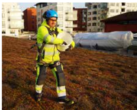
Gödsling av sedumtak.
